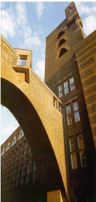
Bild: Turm und Brücke AEG Berlin
